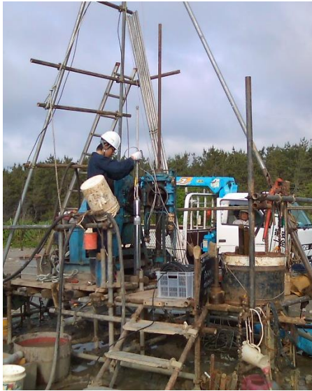
地中計挿入状況
