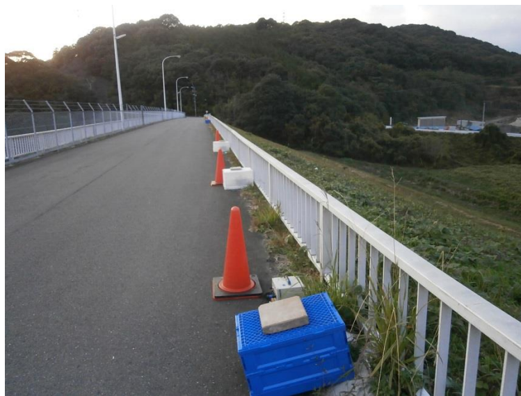
農業用ダム堤体上での常時微動測定例
