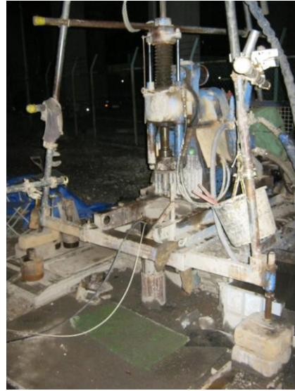
地中計(VSE355D6M)測定状況
